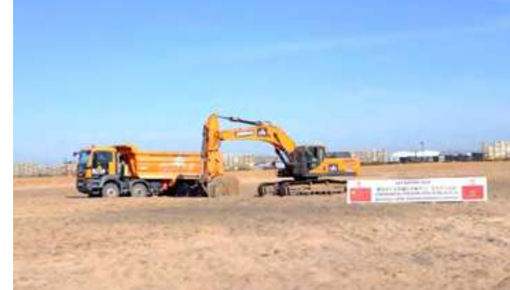
Premier coup de pioche du projet de la nouvelle usine du Groupe Dicastal
